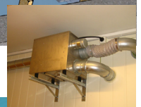
Når rotoren i avfukteren tørkes, sendes våt luft fra denne tørkingen ut via et rør gjennom ytterveggen.
